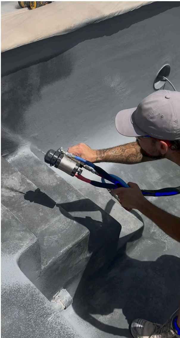
Applicatie van het membraan in de hoeken en rondingen
