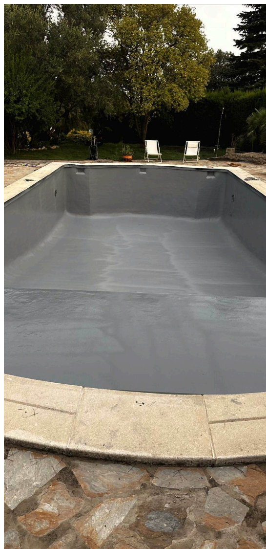
Naadloos aangebracht membraan, klaar voor de toplaag
