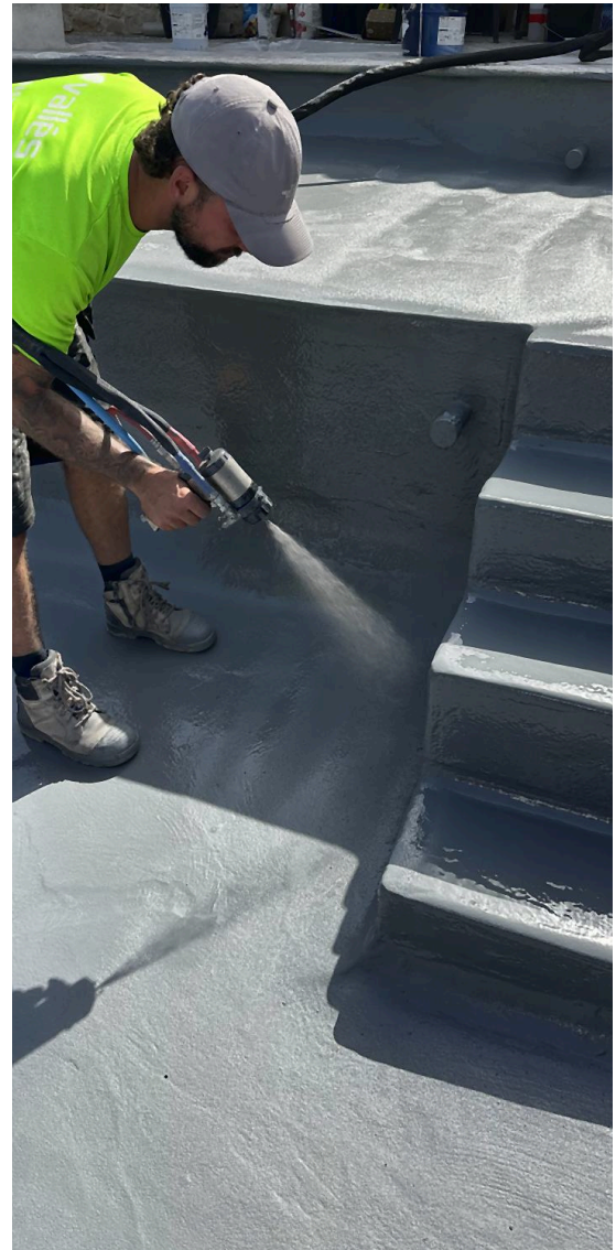
Applicatie van het membraan op trappen en wanden
