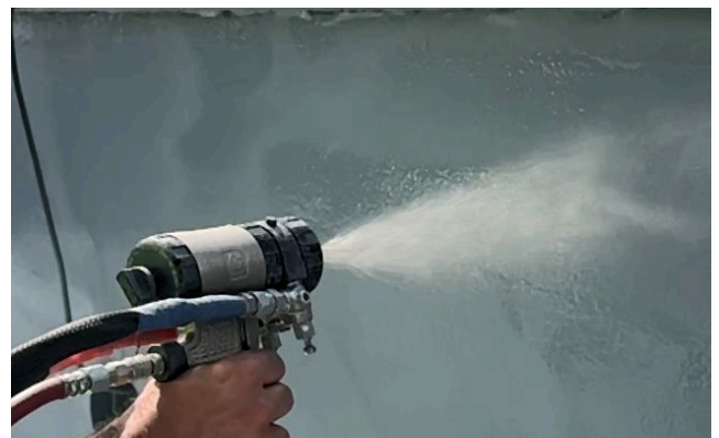
Wandapplicatie met tweecomponenten-spuitapparaat
