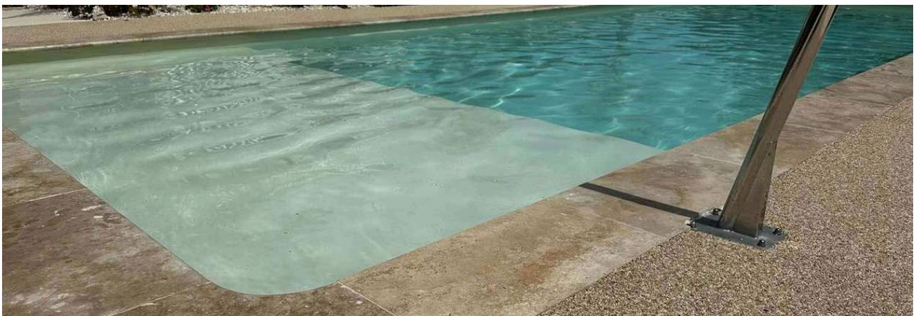
— De travertijnen rand en de chromen douche van het opgeleverde bad
