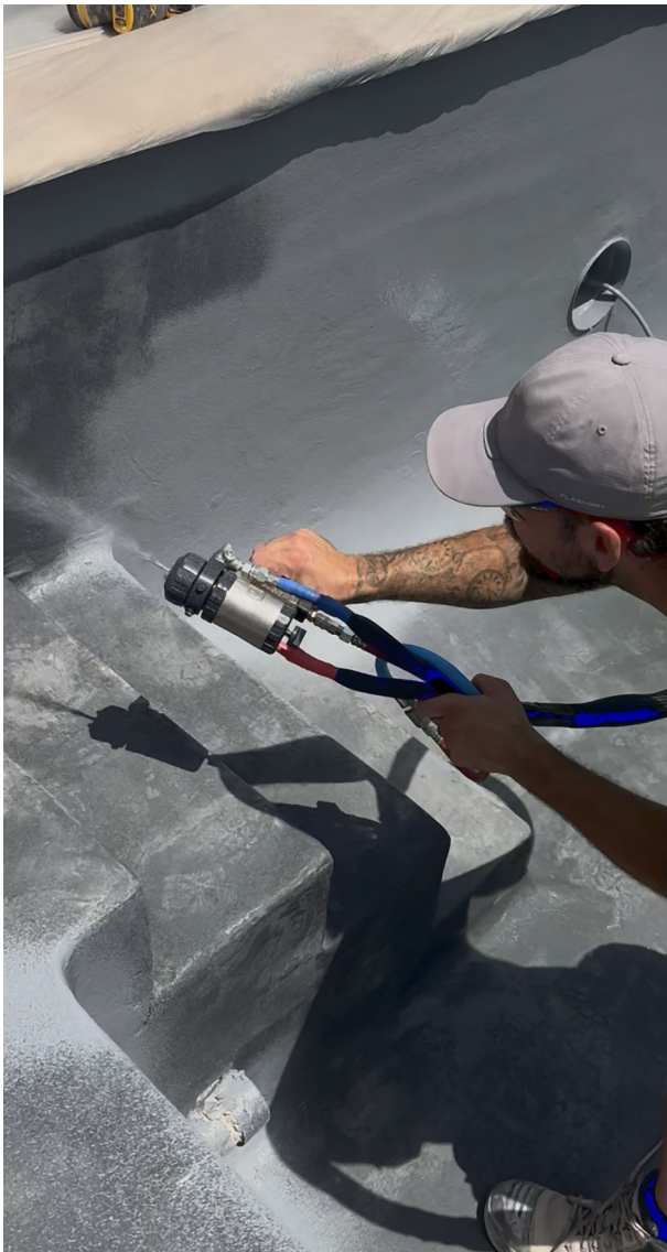
Aplicación de la membrana en esquinas y curvas
