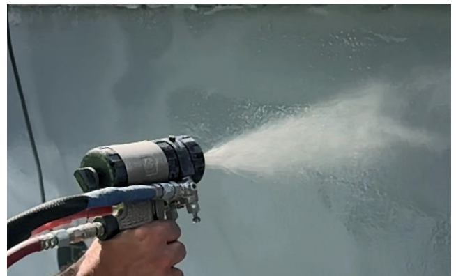
Aplicación en pared con equipo de proyección bicomponente
