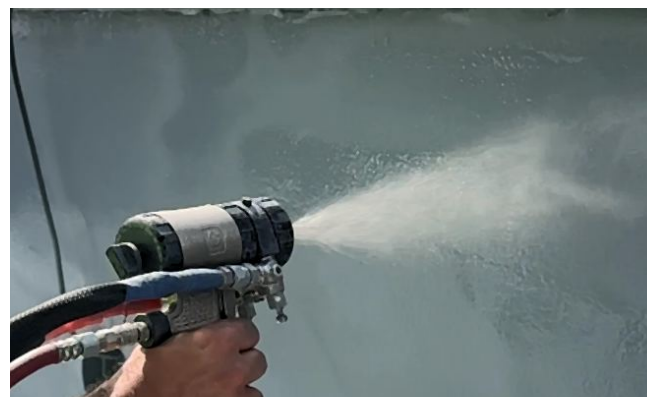
Wandapplikation mit Zweikomponenten-Spritzausrüstung
