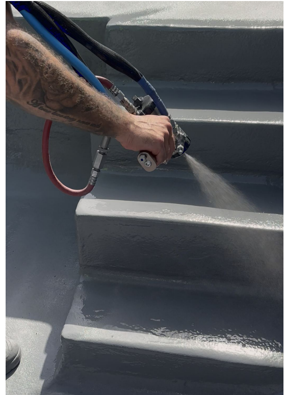
Applikation auf der Treppe: Schicht für Schicht bis zur erforderlichen Dicke
