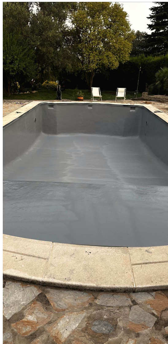
Nahtlos aufgetragene Membran, bereit für die Deckschicht
